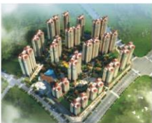
> 桂林精通-伊顿小区
